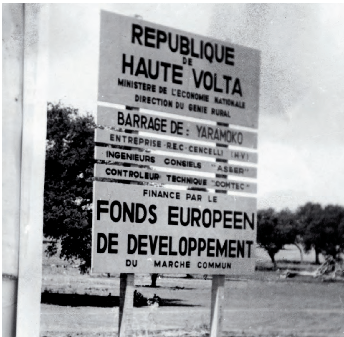
Mars 1965, le Fonds européen de développement finance la construction d'un barrage à Yaramoko en Haute-Volta, aujourd'hui Burkina Faso.
