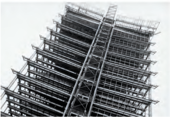
Construction du bâtiment Berlaymont conçu par l'architecte Lucien De Vestel en collaboration avec Jean Gilson et Jean et André Polak. Ce bâtiment de treize étages en forme de croix est composé de quatre ailes de dimensions inégales construites sur pilotis. Parallèlement à cette édification, le gouvernement belge aménage le quartier : élargissement de la rue de la Loi, construction de deux tunnels routiers, d'un tunnel pour le métro et réouverture d'une gare ferroviaire.
